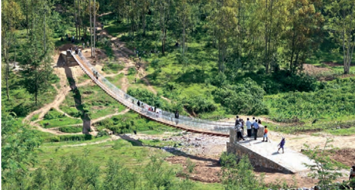
< Kleine Brücke, große Wirkung. Mit dem Hilfsprojekt "Bridges to Prosperity" sichert HOCHTIEF Menschen in entlegenen Teilen der Welt den Zugang zu Bildung, Medizin und Versorgung.
